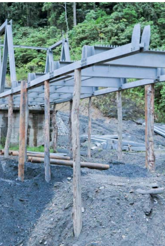
Truk tangki BBM Pertamina melintasi jembatan yang sedang dibangun di Dagewo Kilometer 148 jalan Trans Paniai-Nabire, Papua, 20 Oktober lalu.
